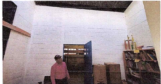
Foto 24: pintura interior, ambiente 6
