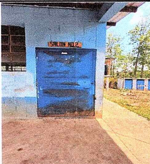
Foto 5: puerta de aula 2 deteriorada, mal reparada mal instalada, requiere sustitución
