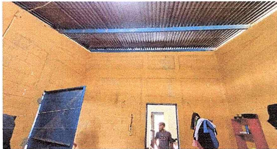
Foto 23: pintura interior, ambiente 5
