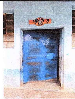
Foto 6: puerta de aula 3 deteriorada, mal hecha, mal instalada requiere sustitución.
