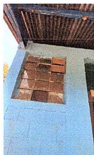
Foto 27: reparaciones de ventanas ambiente 3, sustitucion de vidrios
