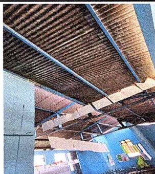
Foto 4: estructura de soporte de metal. Aula 1
