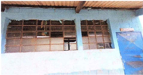
Foto 25: reparacion de ventanas, ambiente 1. sustitucion de vidrios
