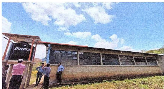
Foto13: sustitucion de canales y bajadas pluviales 2
