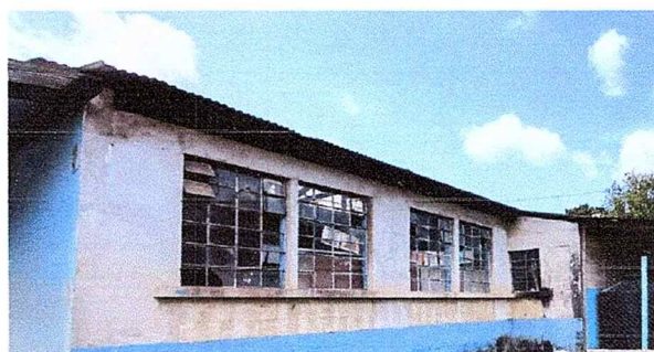
Foto 26: reparaciones de ventanas, ambiente 2. sustitucion de vidrios
