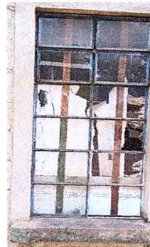
Foto 28: reparaciones de ventana ambiente 4, sustitucion de vidrios
