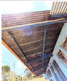
Foto 3: estructura de soporte de metal. Aula 1
